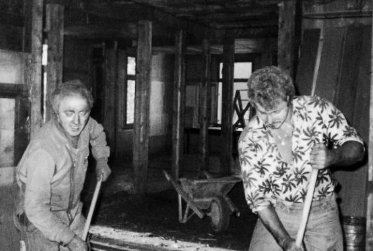
Max Kaufmann und Werner Roos beim Entfernen der Schlacke in der Gaststube.
