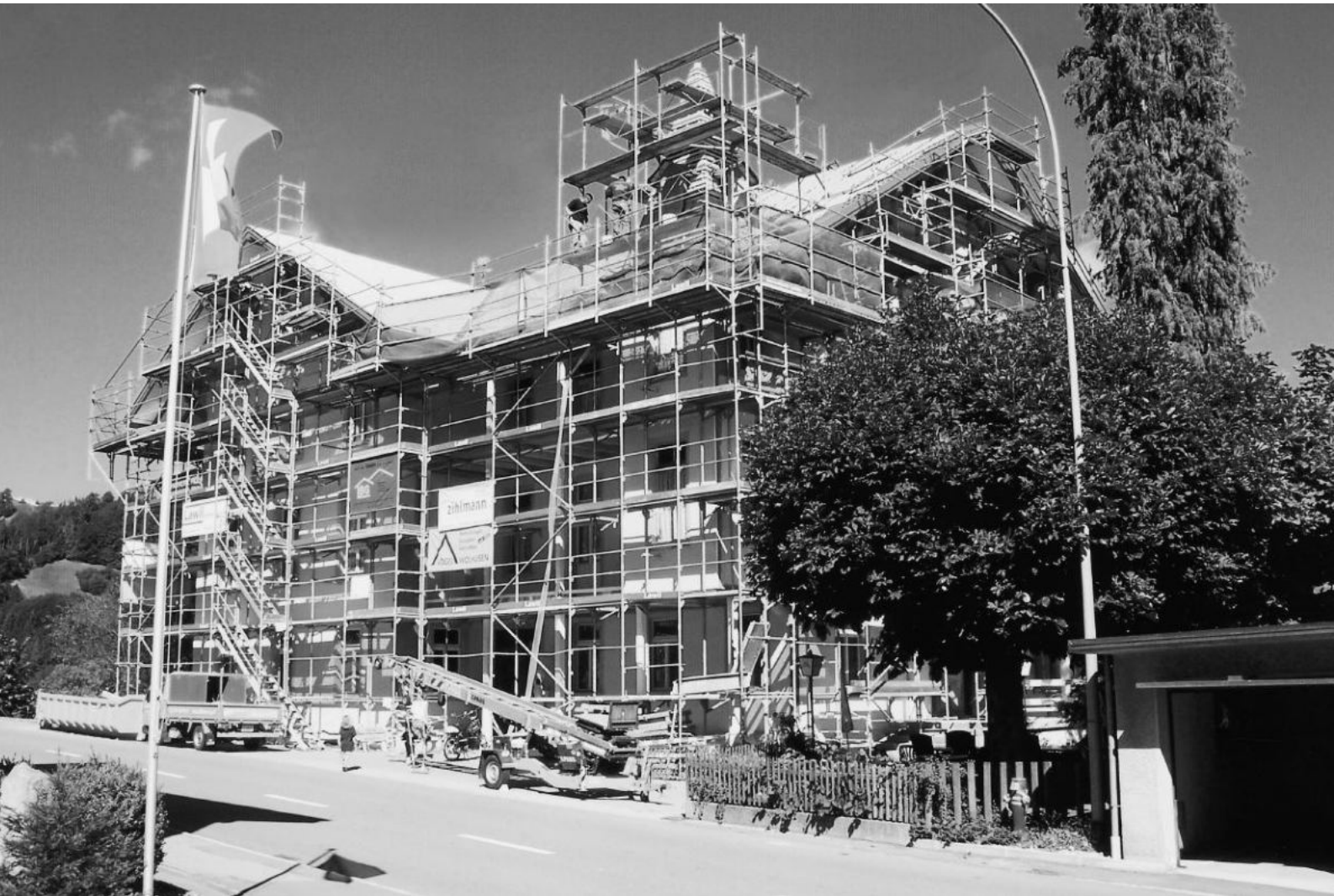
Im Sommer 2006 war das ganze Haus eingerüstet (Doppelgerüst zirka 2500 m 2 ).
