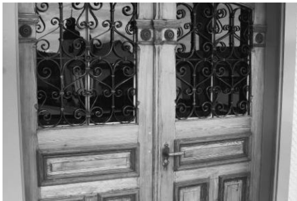
Die Eingangstüren wurden restauriert.
