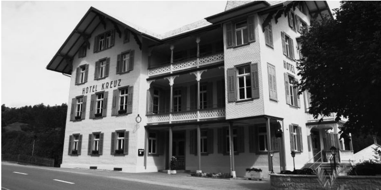
Das neu renovierte Hotel Kreuz, ein markanter Bau im Dorf Romoos.
