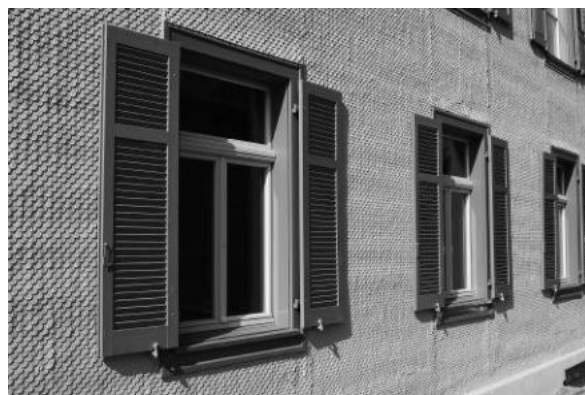
Die ganze Fassade ist mit Schindeln verkleidet.
