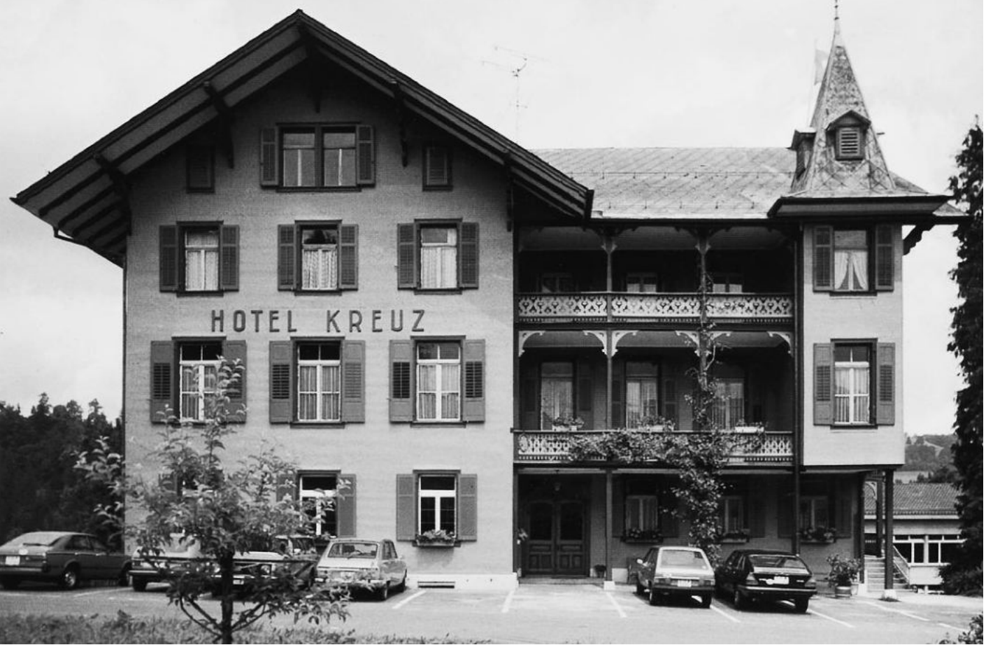
Die Fassade und die Fensterläden sind repariert und frisch gestrichen. Neue Fenster im Parterre und im ersten Stock.
